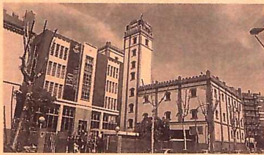
Sede central de Damm en Barcelona. /E.R.
